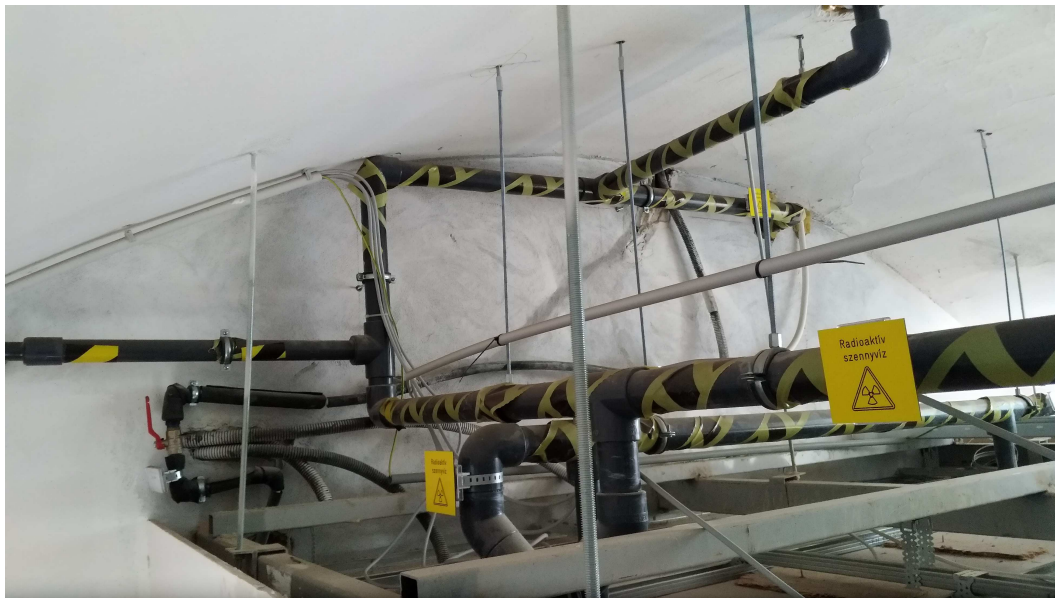
bontandó álmennyezet és gépészet a pincszinti gépészeti térben
